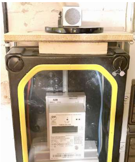
Entstörung des Stromzählers mit 120er-Ronde und Ocean Cube.
